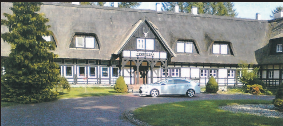
Łańsk - budynek główny - wrzesień 2017
