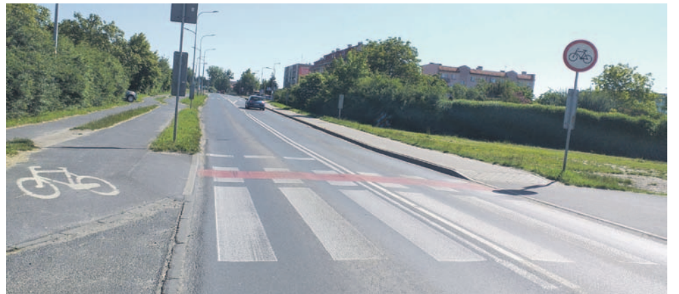
To przejście pieszo-rowerowe, które obecnie znajduje się przed przejazdem kolejowym, zostanie zlikwidowane. Nowe będzie kilkadziesiąt metrów bliżej miasta
