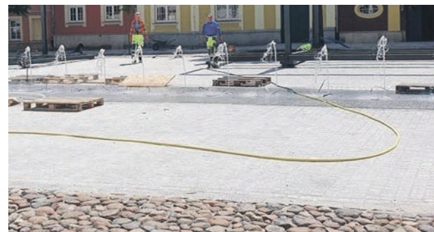
Pierwsze próby instalacji wodnej
