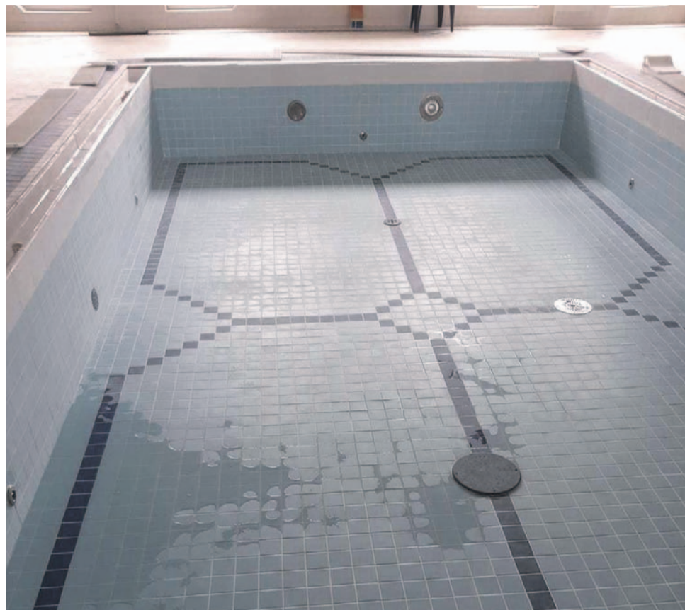
Wymieniono już m.in. lampy i fugi w małym basenie
