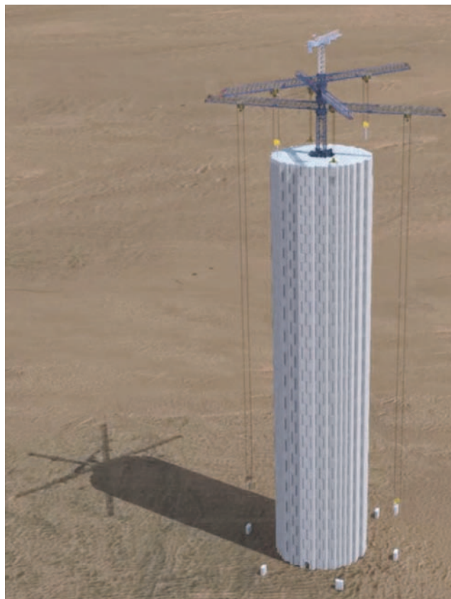
Ta symulacja pokazuje, jak to może wyglądać, choć w szczegółach oławsko-szwajcarskie rozwiązanie zapewne będzie nieco inne. Na pewno jednak ten wielki obiekt, który widać będzie niemal z każdego miejsca powiatu, kształtem i wysokością przypominać będzie słynną wrocławską Sky Tower
