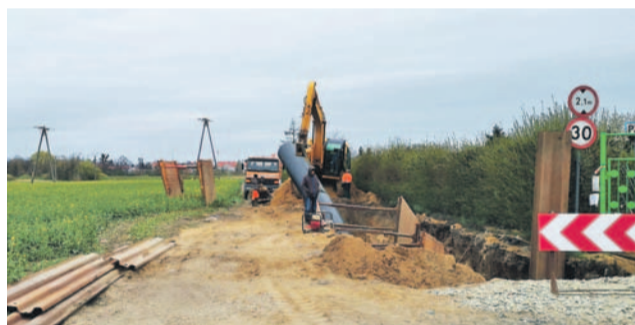
Budowa kanalizacji trwa
