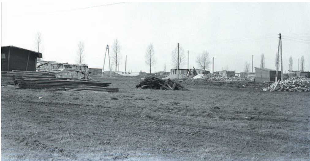
1972 - to zdjęcie zrobiłem z dzisiejszej ul. Kochanowskiego w kierunku drogi na Wrocław, Rozpoczyna się budowa osiedla domków jednorodzinnych na „Gagarina”
