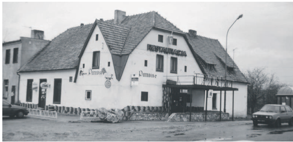
W tym budynku po wojnie do 1976 mieściła się wiejska świetlica, przy wjeździe od Nowego Górnika. Potem GS Oława, po remoncie, uruchomiła tu gospodę „Turystyczną”, po latach zmieniała kilka razy swoją nazwę i właściciela. Dziś tego obiektu już nie ma...
