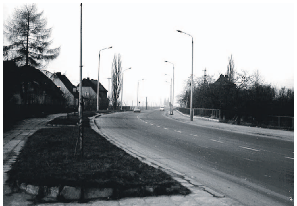
1975 rok - ul. Kutrowskiego. W głębi widoczna droga na Wrocław, a po lewej było pole, na którym rosło zboże, a później rzepak. Dziś lewa strona jest zabudowana pawilonami handlowymi i zakładami pracy
