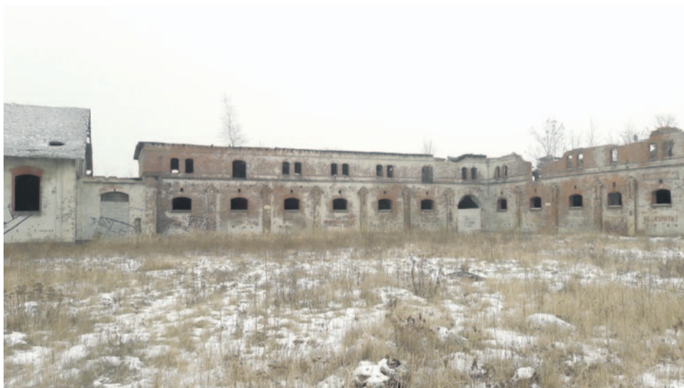
Tak było przed rozpoczęciem przebudowy
