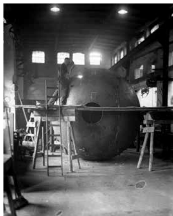
Ryc. 13. W zakładach powstawały spawane zbiorniki ciśnieniowe
