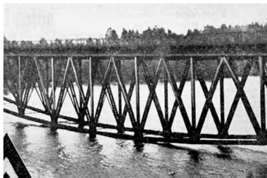
Tak wyglądało Jezioro Pilchowskie w 1938 r. w okolicy mostu, lustro wody dotykało przeset. W 1997 roku wysokość zapory nie wystarczała, woda przelewała się przez wybudowany celowo upust kaskadowy.
