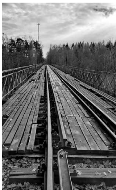
Ryc. 19. Stan torów kolejowych na pamiątkowym moście w Pilchowicach. W środku toru szerszego umieszczono tor dla wąskotorówki. Obecnie nieczynna linia kolejowa.
