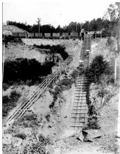
Ryc. 2. Takimi pochylniami staczano materiały budowlane, a po I w. św. sprzęt wojenny na dno przed Zaporą. Zdjęcie z portalu Strzyżowiec na FB.
