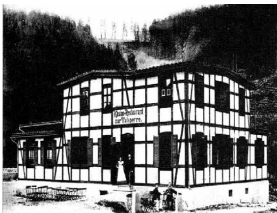
Kasyno – restauracja „Nad Zaporą” z czasów budowy Zapory Pilchowskiej było czynne 2 – 3 lat, rozebrane kilkanaście lat po zakończeniu budowy. Restauracja służyła jako stołówka dla pracowników. Budynek usytuowany poniżej zapory, w strefie zalewowej, w czasie wielkiej wody groziło mu zmycie przez falę powodziową.
