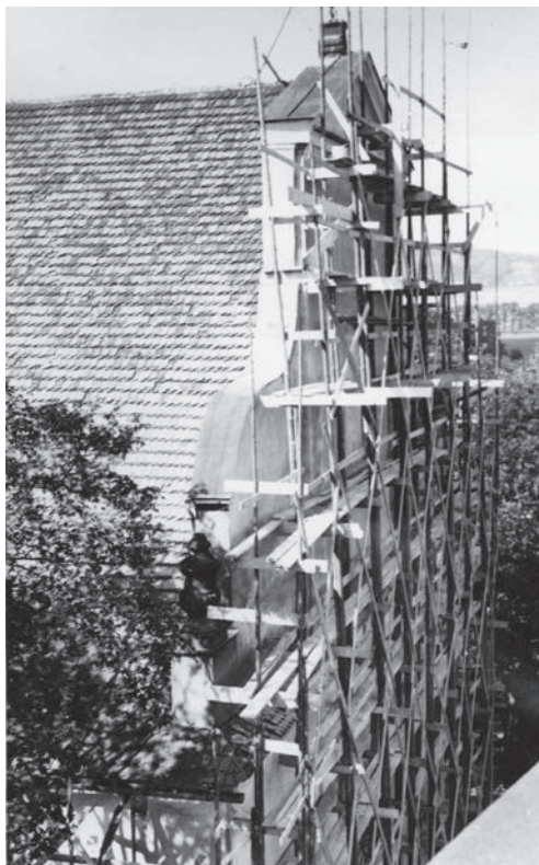
Ryc. 38. Elewacja wschodnia kościoła św. Jana Chrzciciela podczas remontu w 1960 r.
