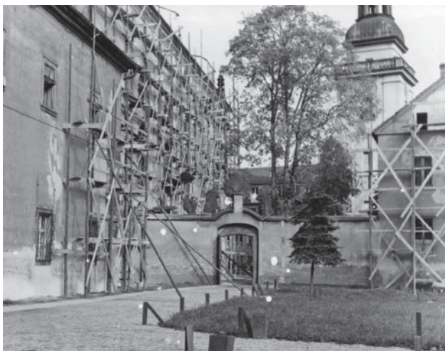
Ryc. 37. Budynek domu pijarów podczas remontu w 1960 r.
