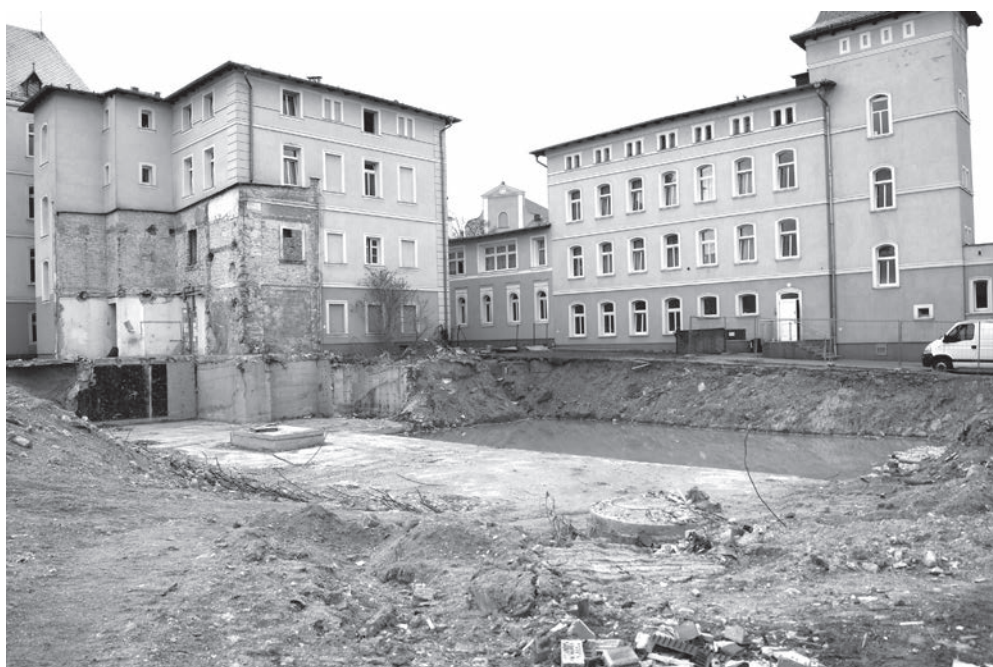
Ryc. 2. Wykop budowlany przy ul. Marysieńki Sobieskiej w centrum Cieplic (fot. S. Firszt)
