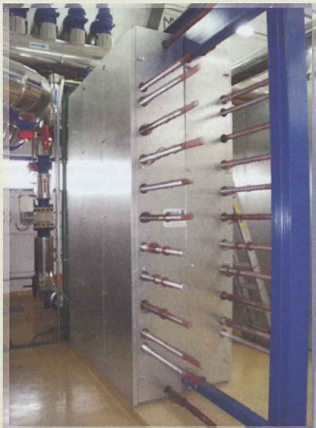
Wymiennik ciepła w zakładzie Geotermalnym Bańska Niżna
