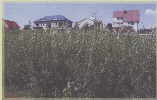
Oczyszczalnia gruntowo - roślinna w Jastkowie koło Lublina -funkcjonuje od 1994 roku
