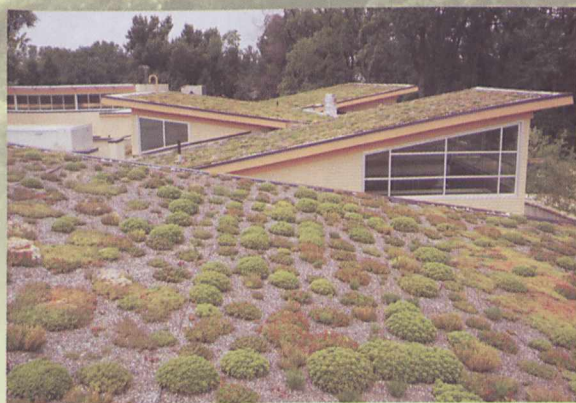
Rozchodnik jest chętnie stosowaną rośliną na zielonych dachach
