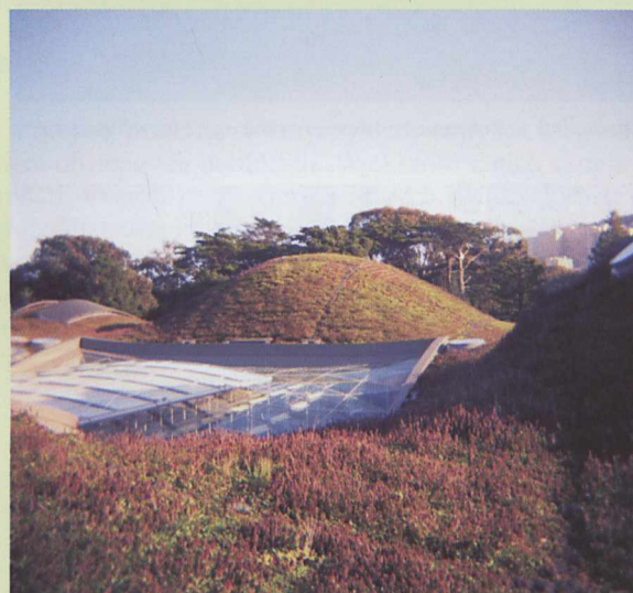
Zielone dachy mogą przybierać różne formy - dach budynku w San Francisco
