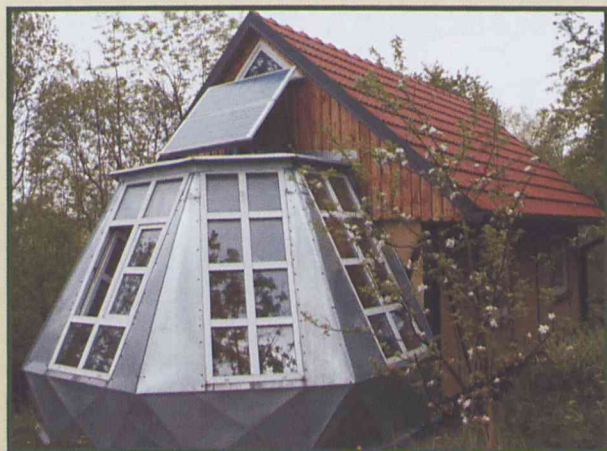
Fot. domek z gliny i słomy z pasywnym dogrzewaniem i modułami fotowoltaicznymi, które produkują prąd.
