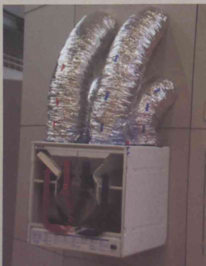
fot. Instalacja wentylacyjna z odzyskiem ciepła pozwala na ograniczenie strat ciepła na wentylację
