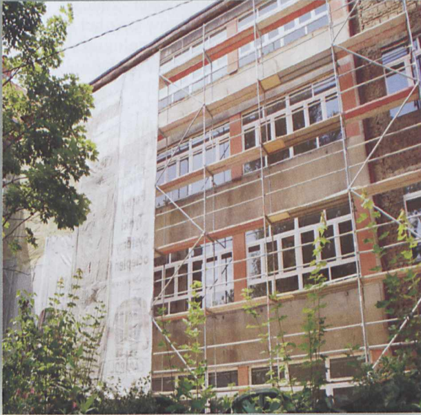
Ryc.1.fot, UM Jelenia Góra, w Jeleniej Górze trwają prace nad ociepleniem budynków szkolnych.
