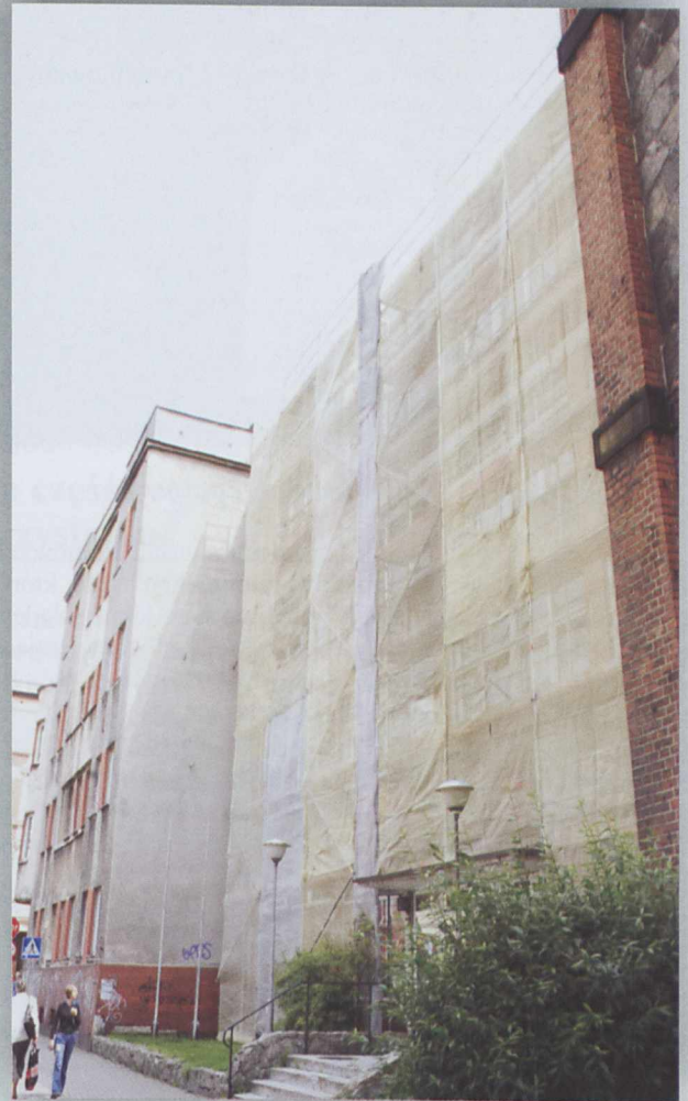
Ryc.2.fot, UM Jelenia Góra, w Jeleniej Górze trwają prace nad ociepleniem budynków szkolnych.
