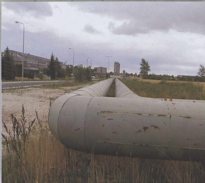
Ryc.1.fot, Zakład Energetyki Ciepłej Sp.z o.o w Bolesławcu Jeszcze w tym roku znikną stare rury przy wjeździe do Bolesławca. Przestaną odstraszać potencjalnych przedsiębiorców, zainteresowanych działalnością w pobliskiej strefie ekonomicznej.
