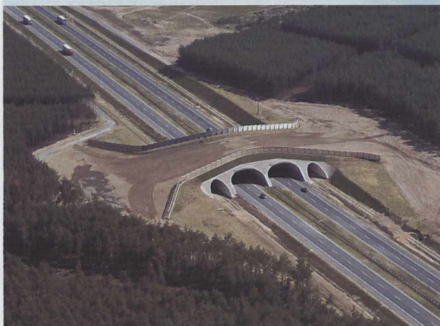
Ryc. 1. Przejście dla zwierząt między węzłami Żdźary i Kolo (fot. Maciej Jeziorek)
