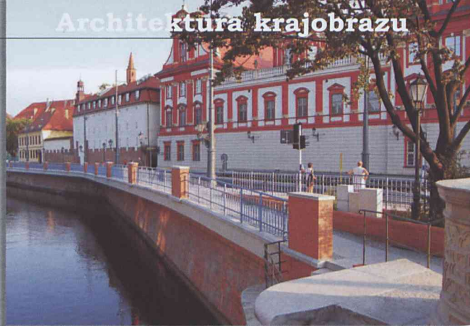
Ryc. 5. Przebudowane w 2007 roku mury oporowe wzdłuż ulicy Grodzkiej naprzeciw Uniwersytetu Wrocławskiego. Ulicę poszerzono nadbudowując i umacniając nabrzeże (fot. E.K.)
