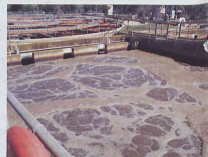
FOT. 3. Po lewej: projekt biologicznej oczyszczalni ścieków w Sianowie; po prawej: zbiornik z osadem czynnym (źródło: http://www.sianow.pl/ekologia/oczyszcz/oczyszczalnia.htm )
