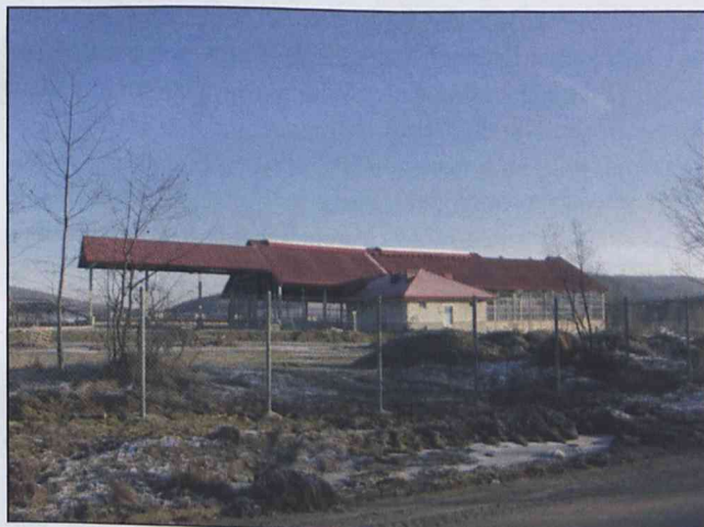
Fot. www.kpb.com.pl Zdjęcie z placu budowy sortowni.
