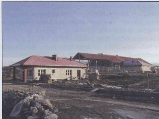
Fot. www.kpb.com.pl Zdjęcie z placu budowy sortowni.
