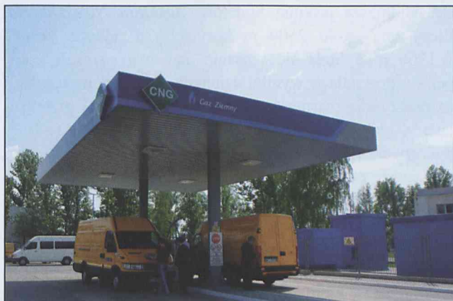
Fot. Stacja CNG należąca do Dolnośląskiej Spółki Gazownictwa
