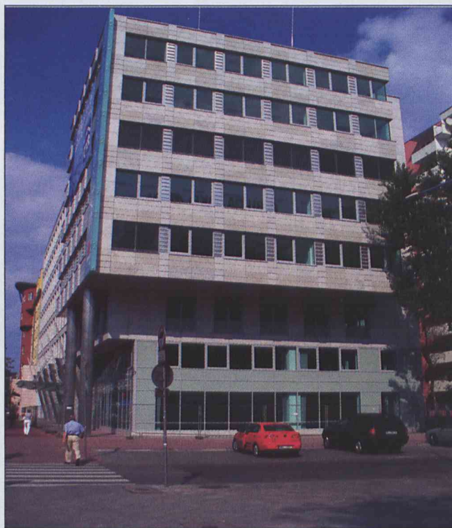
Fot. Luiza Kaluska. Biurowiec przy ul. Dalekiej w Warszawie. W obiekcie zastosowano osłonę przeciwsłoneczną - żaluzje fasadowe zewnętrzne WAREMA, które podnoszą walory estetyczne budynku.
