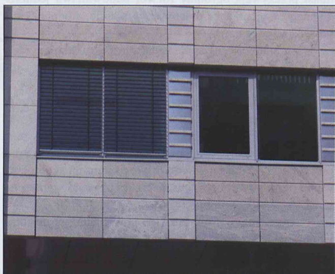
Fot. Luiza Kaluska. Okno z żaluzjami opuszczonymi i podniesionymi.
