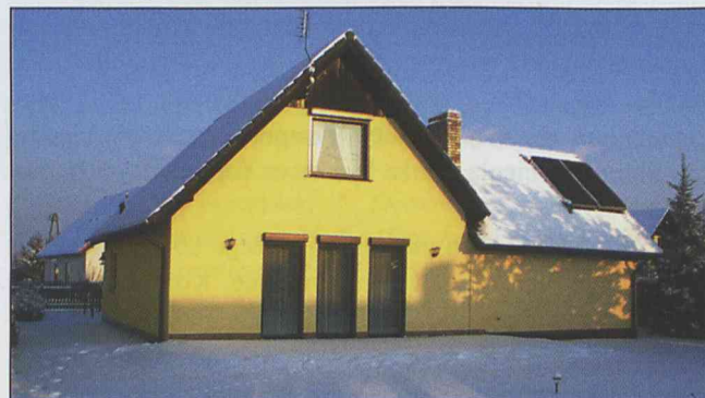
Rys. 4. Widok stanowiska badawczego z zainstalowanymi kolektorami słonecznymi na południowej połaci dachu.
