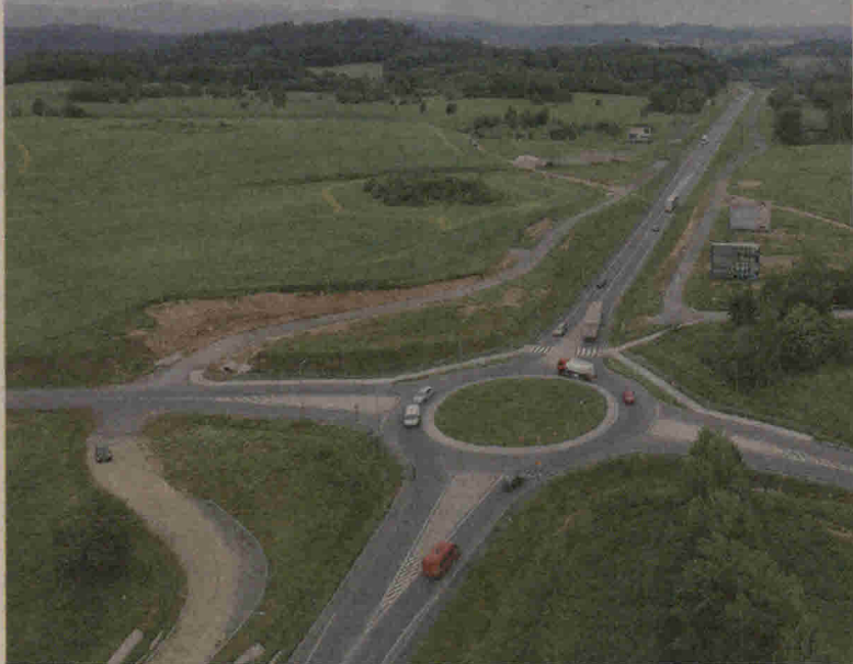
Budowa obwodnicy Maciejowej jest jedną z najważniejszych inwestycji drogowych Miasta nie tylko w 2019 roku, ale i w ostatnich latach.
