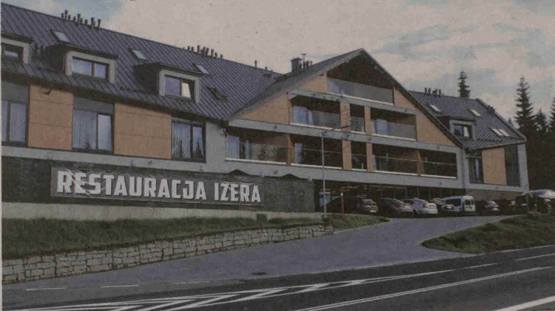
Hotel Jakuszyce w oczach architektów zasłużył na Mistra Architektury.
