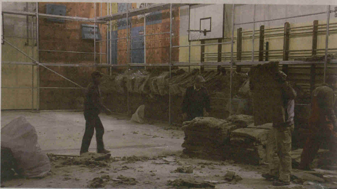
W sali prace trwają pełną parą.
