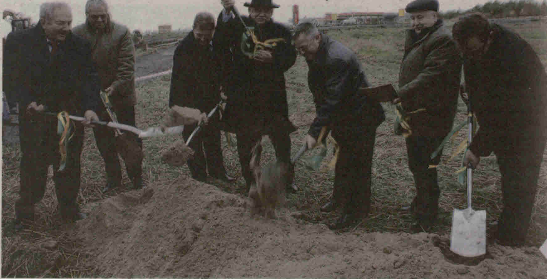
Pod Jędrzychowicami stanie 37 wiatraków. Na zdjęciu oficjele rozpoczynają budowę.
