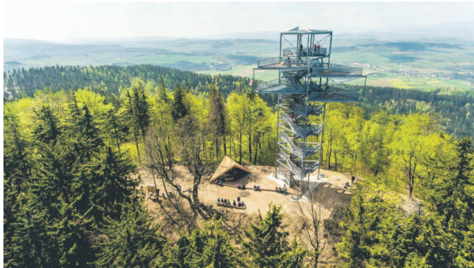
Wieża składa się z platform widokowych na pięciu kondygnacjach.
