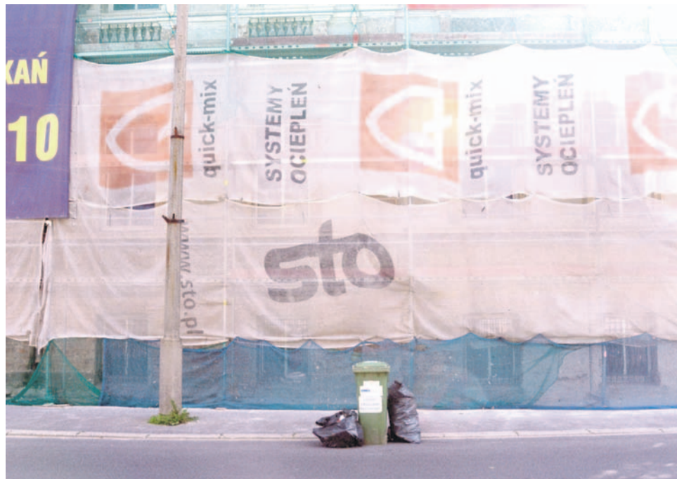
Śmieci przez cały dzień stały na oławskiej ulicy przed remontowaną kamienicą - zabrali je dopiero pracownicy ZGK z Jelcza-Laskowic
