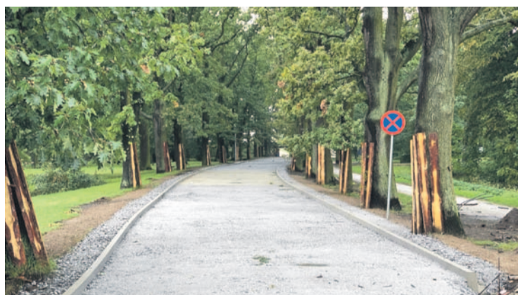
Trwa budowa ul. Spacerowej. Droga przez park jest zamknięta dla samochodów
