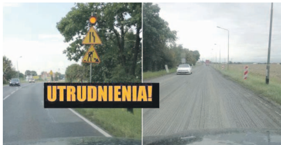
Na Opolskiej wprowadzono odpowiednie oznakowanie. Już część nawierzchni została zdjeta, prace idą szybko
