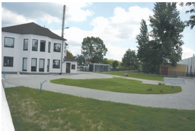
Plac manewrowy jest już prawie gotowy
