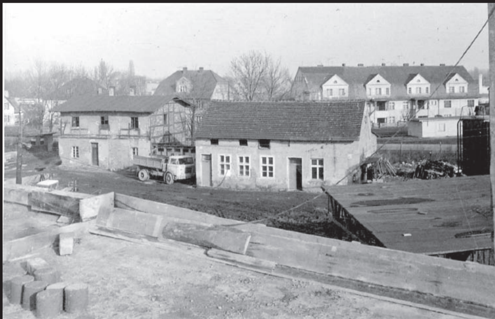
1974 - widok z wiaduktu w kierunku ul. Różanej
