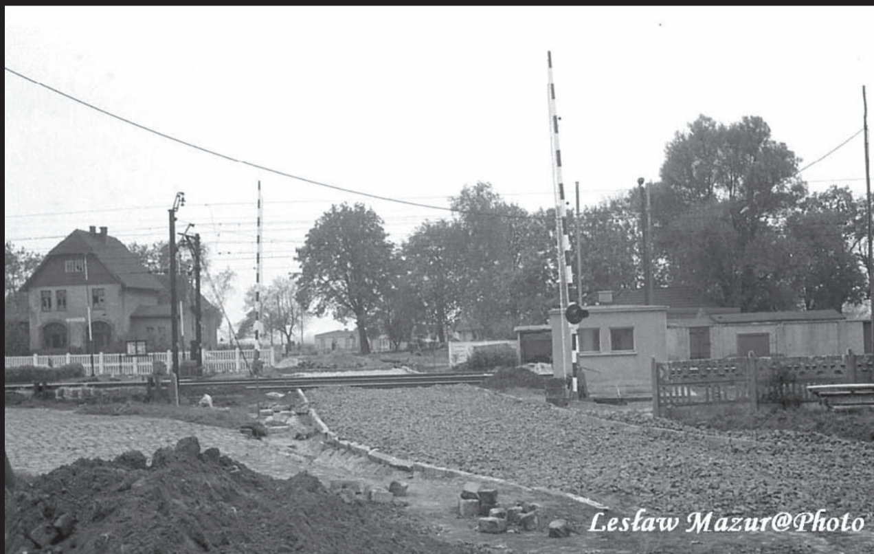
1971 - budowa prowizorycznego przejazdu na czas budowy wiaduktu. Po lewej stronie budynek, w którym kiedyś mieściła się stacja kolejowa linii Olawa - Boreczek
