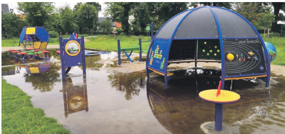
Tak wyglądało podwórko przy ul. Bursztynowej po intensywnych opadach. Woda nie spływała. Urzędnicy obiecali, że zajmą się problemem
