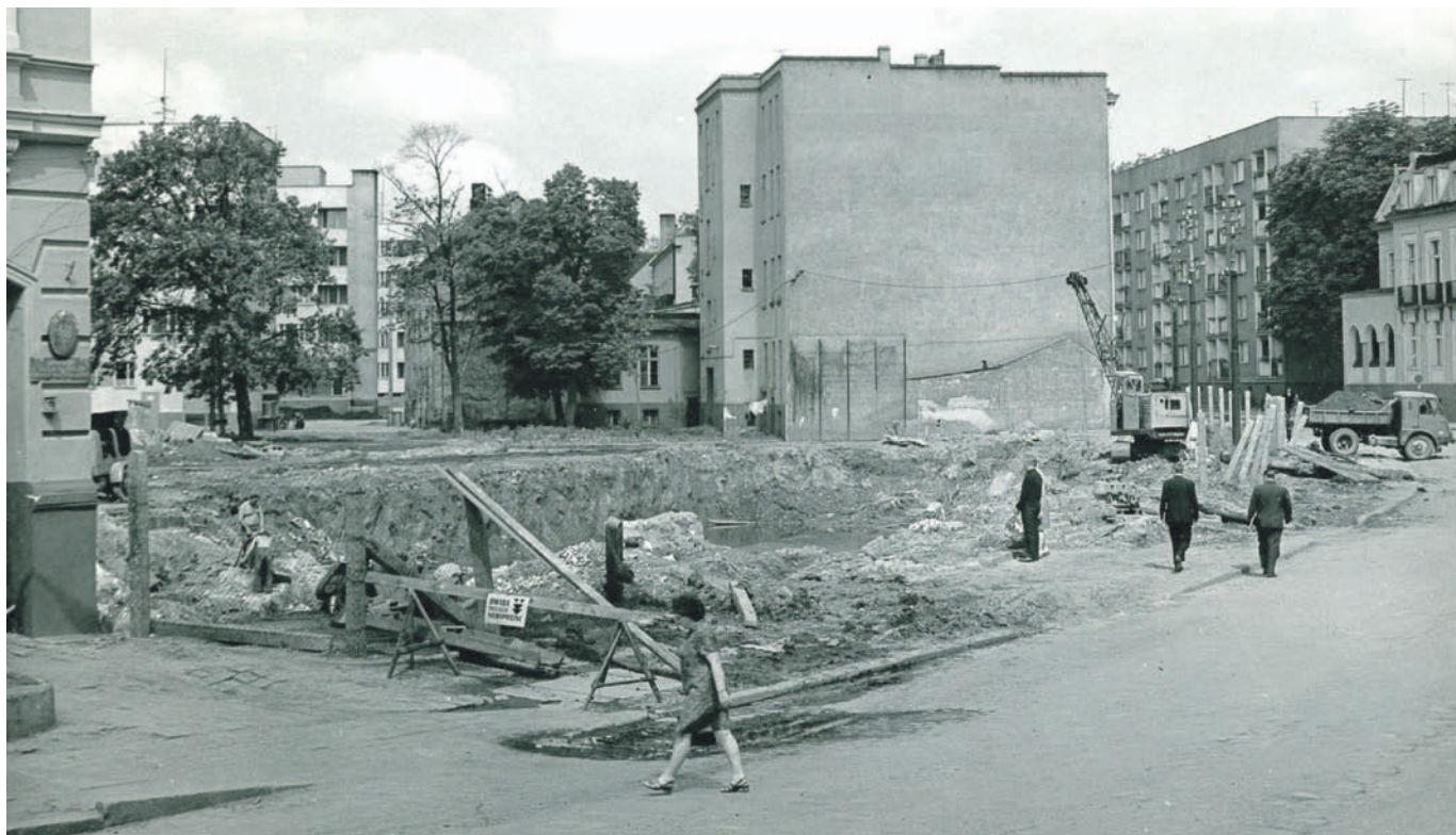
Zdjęcie nr 8 - 1971 rok, ul. 1 Maja - w tym miejscu powstanie budynek pod numerem 13. Pamiętam, że prace przy fundamentach były bardzo trudne. Z powodu tzw. kurzawki „utonął” spychacz, którego nie mogły wyciągnąć dwa dźwigi o nośności 10 ton
