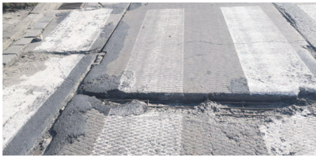
Cała ulica Paderewskiego jest złym stanie, ponieważ wyłożona jest starymi płytami z poniemieckiego lotniska, które hałasują i rezonują, kiedy przejeżdżają auta
