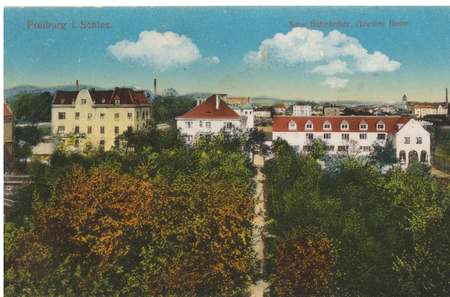
Ulica Kolejowa - widok od strony zakładu „Rafio”
