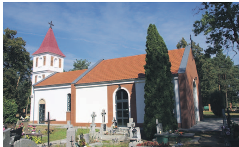
Rozbudowa kaplicy na cmentarzu komunalnym przy ul. Chwałowskiej
