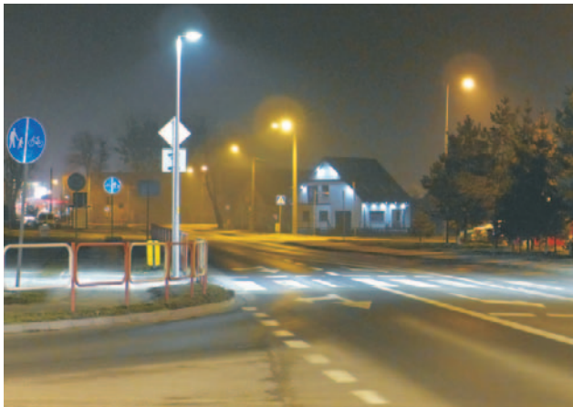
Program „Bezpieczne przejścia” - nowe oświetlenie na ul. Wiejskiej
