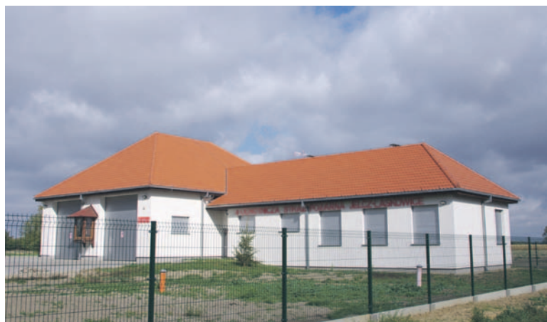
Budowa remizy OSP w Jelczu-Laskowicach
