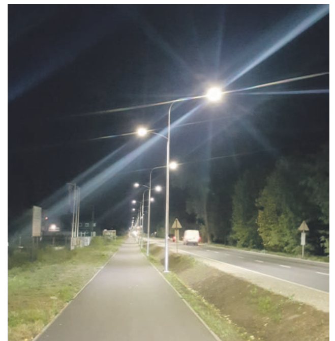
Wzdłuż ul. Nowy Otok powstała ścieżka pieszo-rowerowa z oświetleniem
