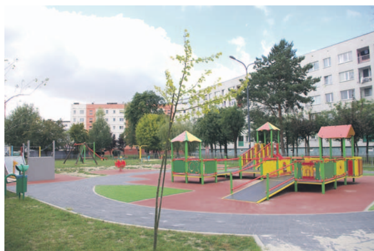
Budowa integracyjnego placu zabaw przy ul. Tańskiego w Jelczu-Laskowicach
