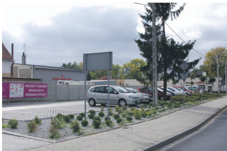
Budowa parkingu u zbiegu ulic Oławskiej i Polnej w Jelczu-Laskowicach
