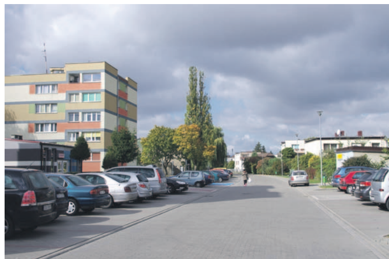
Przebudowa ul. Liliowej w Jelczu-Laskowicach
