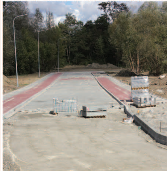
Budowa parkingu park & ride w raz z dojazdem i ścieżką rowerową przy stacji PKP w Jelczu Laskowicach od osiedla Hirszfelda
