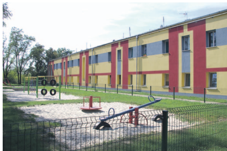
Modernizacja budynku przy ul. Techników 16 w J-L w zakresie instalacji wewnętrznych wraz z budową placu zabaw
