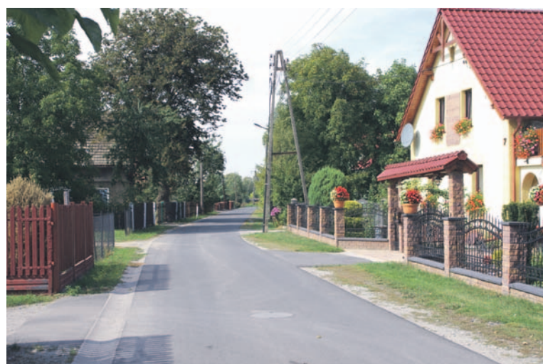
Przebudowa ul. Pocztowej w Miłoticach
