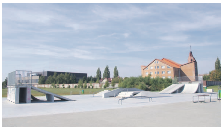
Budowa skate-parku w Jelczu-Laskowicach
