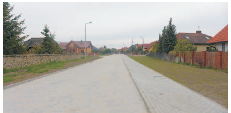
Ul. Małopolna jest jedną z 6 nowo wybudowanych dróg w tym rejonie miasta
