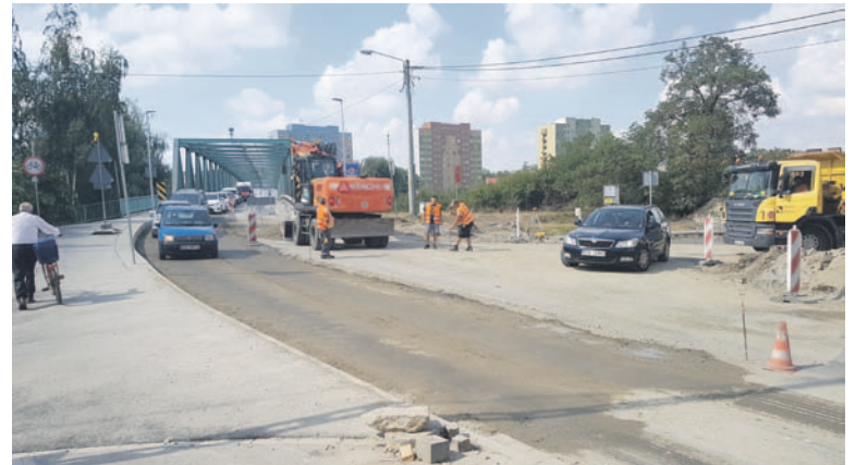
Oleśnicka - przebudowa drogi wojewódzkiej
