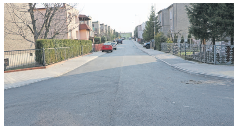
Ul. Bratków za wiaduktem po remoncie nawierzchni i chodników
