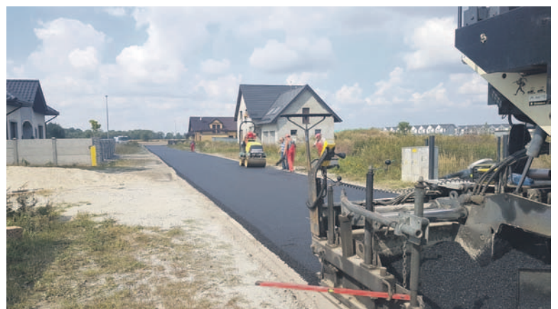
Utwardzanie dróg gruntowych masą bitumiczną w Nowym Otku i Nowym Górniku
