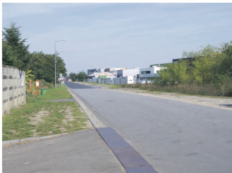
Przebudowa ul. Polnej w Łęgu
