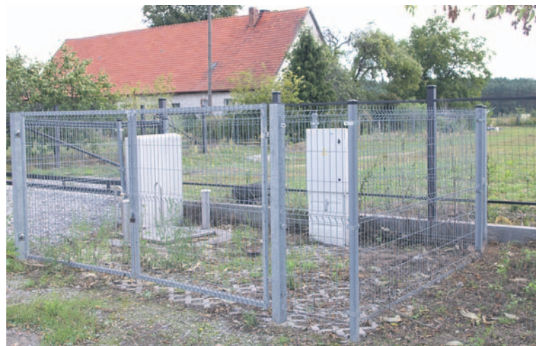
Budowa kanalizacji sanitarnej w Miłoticach
