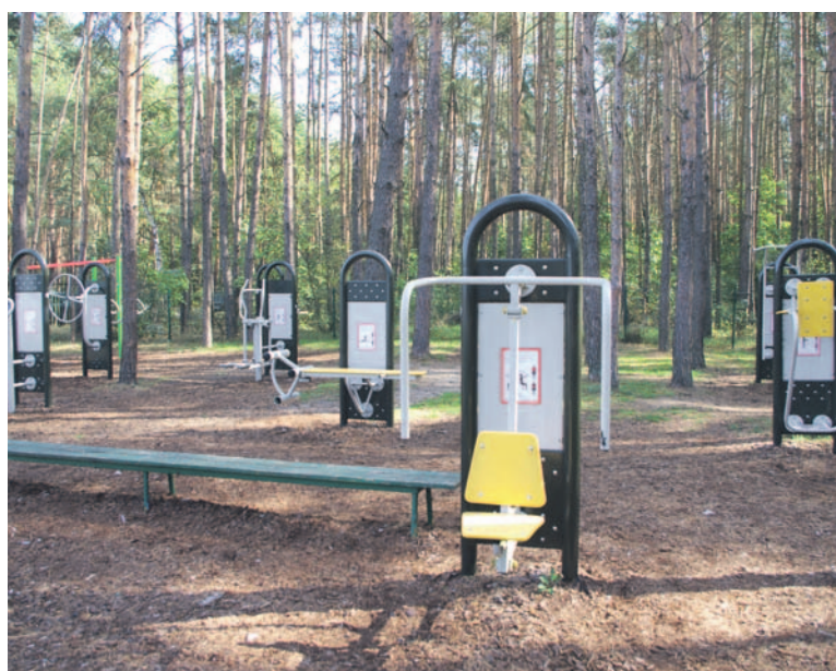
Budowa siłowni plenerowej przy Ośrodku nad stawem w Jelczu-Laskowicach
