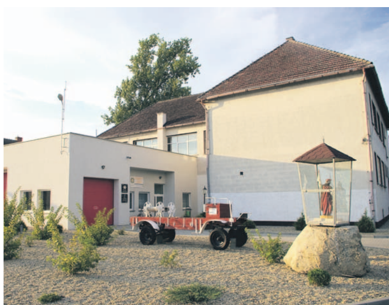
Rozbudowa remizy OSP w Minkowicach Oł.
