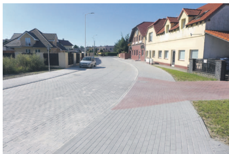
Ul. Braci Gierymskich - jedna z 5 nowo wybudowanych dróg na osiedlu za strażą pożarną
