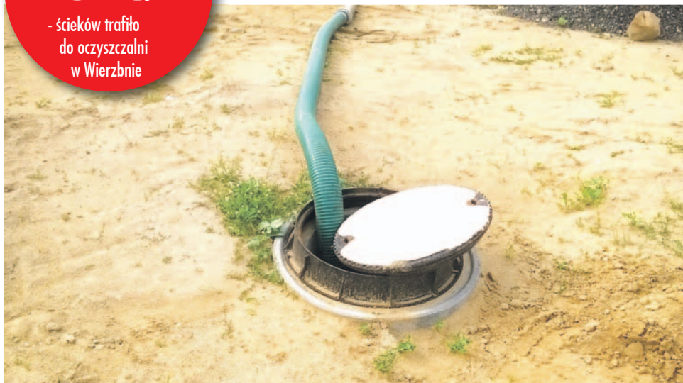
Rozbudowa kanalizacji sanitarnej w Wierzbnie (6,7 km) ma się zakończyć do połowy 2019 roku
