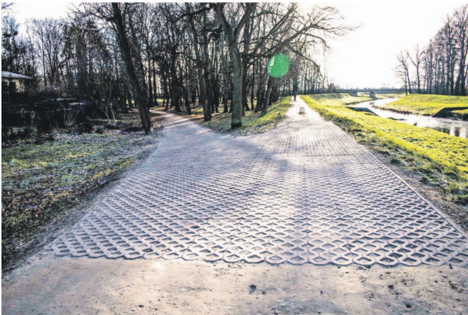
15 metrów tej nawierzchni wywołuje burzliwą dyskusję
