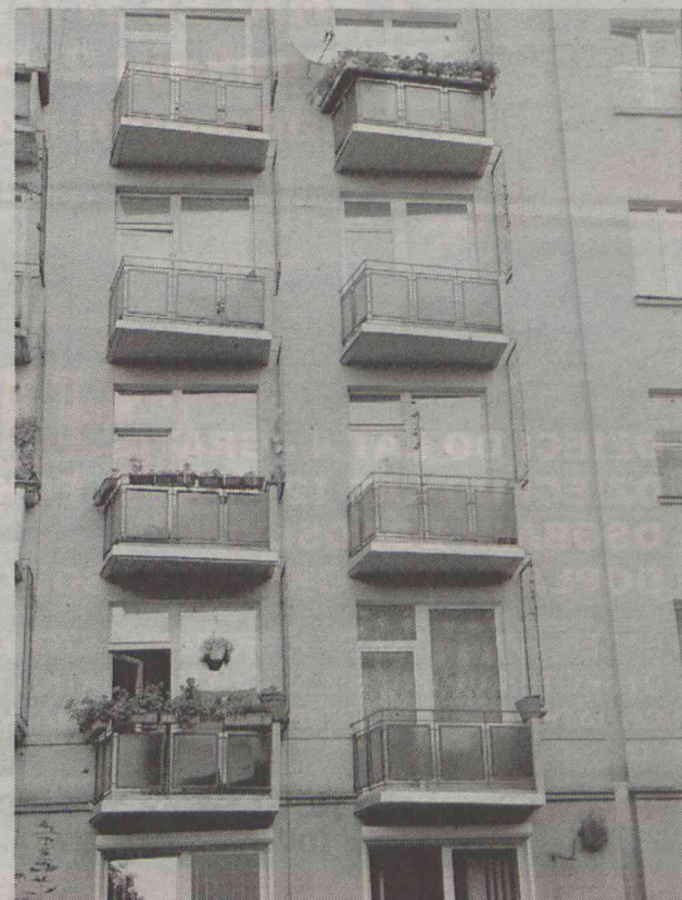
Wyremontowano balkony przy Piłsudskiego 39
