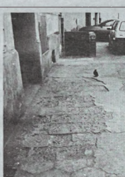
Naprawiony zostanie chodnik przy ul. Pilsudskiego 32
