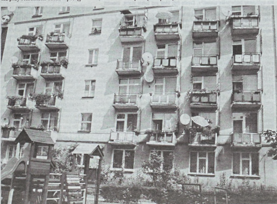
Czyszczenie balkonów przy ul. Piłsudskiego 39
