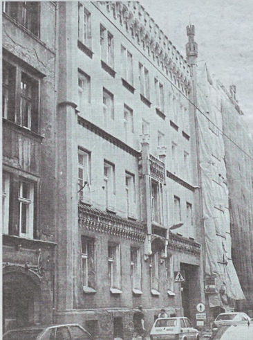
ul. Włodkowska 3 - remont dachu
