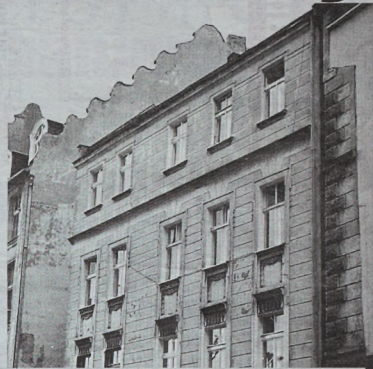
ul. Św. Antoniego 8 - tu będzie remontowany dach
