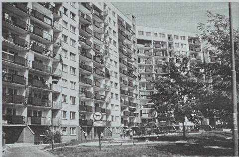
ul. Gwarkica – już po remoncie elewacji
