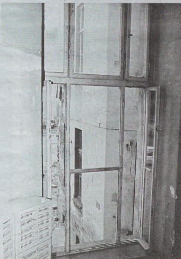
na ul. Włodkowska 33, zaplanowana została wymiana okien na klatkach schodowych
