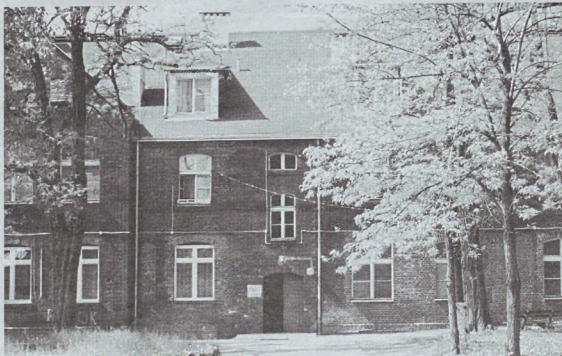
ul. Zwirowa 71 – remont dachu został już wykonany
