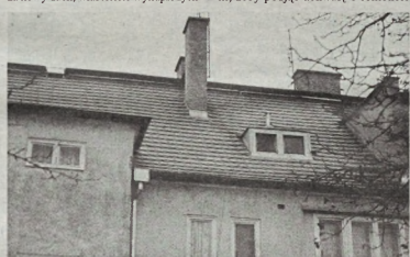
Wyremontowany przez czterech lata dach wygląda świetnie i lokatorzy nie żałują, że zdecydowali się na niego wymyć.
