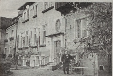
Dzięki remontowi, wspólnota w miejscu kotłowni i składu opału zyskała nowe pomieszczenie, które zachęca właścicieli do wyodrębnienia. Dom przy ul. Kochanowskiego 7-9 jest elektryczny, rozległy i otoczony atrakcyjnym ogrodem.
