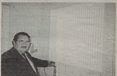
W mieszkaniu Wiesława Malusa są już zamontowane efektywne i nowoczesne grzejniki, ale rozruch ogrzewania nastąpi dopiero 15 listopada.
