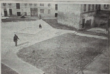
Wyremontowane, zagospodarowane wnętrza podwórzowe przy ul. Jedności Narodowej nieustępi się bardzo okładzie. Wzręc „na pasuje” do otoczenia.
