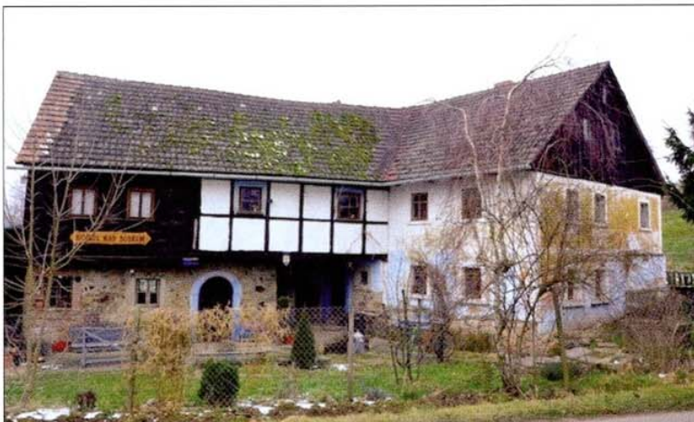
Alte Schmiede in Dippelsdorf / Przeździedza
