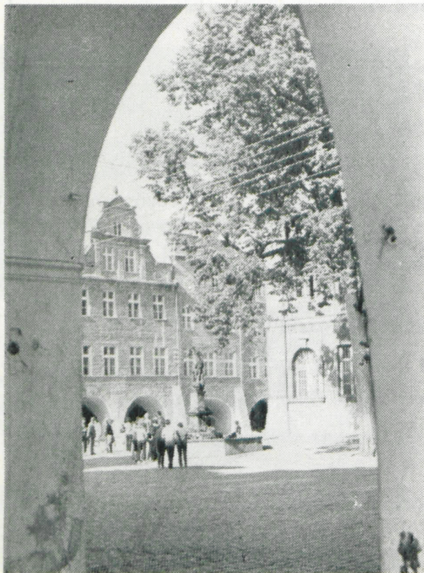
Fragment odbudowanych arkad przy placu Ratuszowym Fot. Adamski
