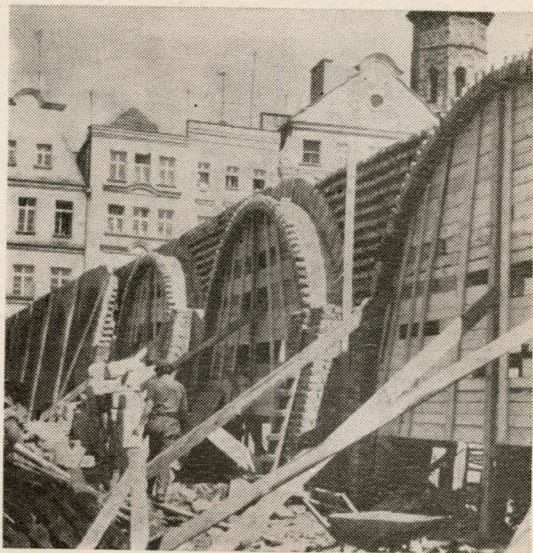
Odbudowa kamieniczek w Ryńku
