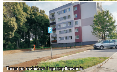
Teren po rozbiórce i uporządkowaniu
