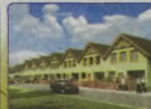
PSIE POLE , dom w zabudowie szeregowej, pow. 126 m 2 , z ogródkiem, stan deweloperski, termin oddania IV kw. 2007 r., Cena: 588.000 zł
