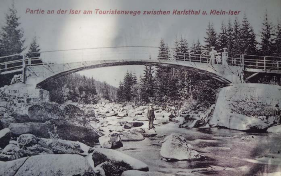
Iser-Betonbrücke im Jahr 1901
