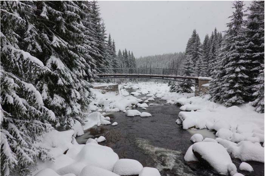
Stahlbrücke über die Große Iser im Dezember 2021
