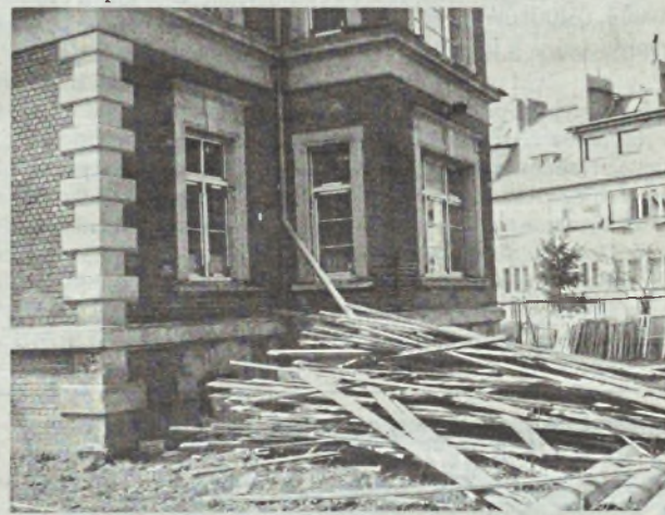
Lokatorzy z Sępólna skarżą się na bałagan wokół remontowanego zabytku.
